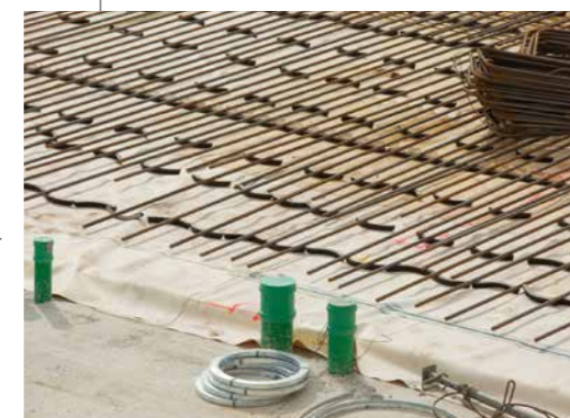
Frischbetonverbundfolie schützt vor Feuchtigkeit
