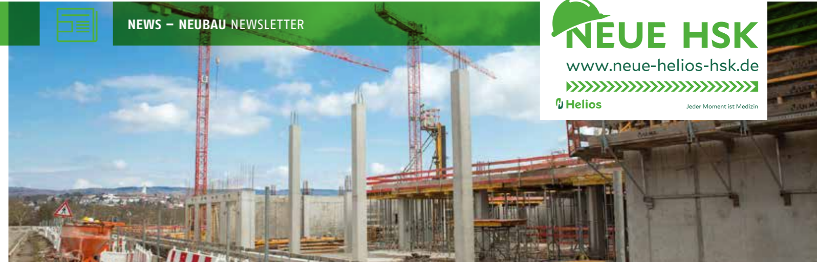
Schon gut erkennbar: Der künftige Eingangsbereich des Klinik-Neubaus mit drei Säulen, auf denen das neun Meter freischwebende Vordach aufliegen und befestigt werden muss.
