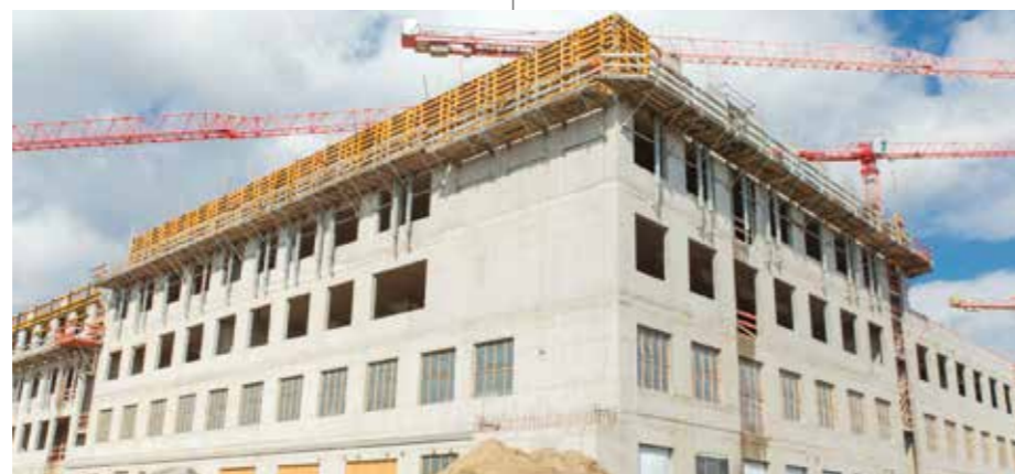
Baufortschritt mit viel Beton und Stahl: Weitere Etagen des 203 Meter langen Klinikgebäudes wachsen in die Höhe.
